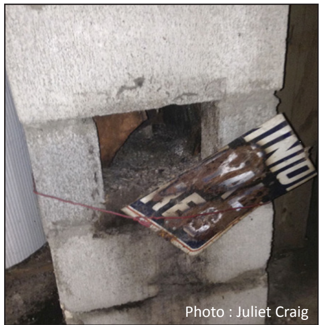
Figure 33. Exemple d'un conduit scellé par le bas alors qu'il devrait être scellé par le haut.
